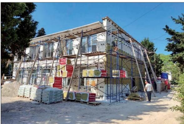
В настоящее время на объекте выполняются отделочные работы, работы по устройству отмостки, полов, подвесных потолков, окон, дверей, систем водоснабжения и водоотведения, электроснабжения, отопления, вентиляции. Строительная готовность – 58 %.
